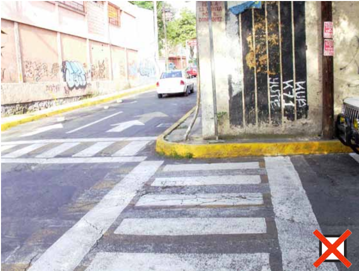
Paso en escalera
